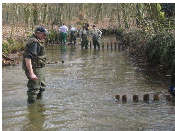
Aanbrengen van 'dood-hout vangere' en kiezelbedden.
