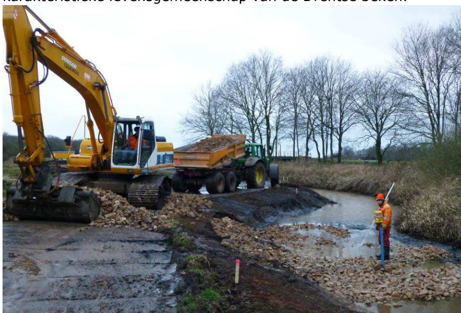
Aanleg grindbed in het Grote Diep, februari 2014 (foto A.J. Scheper).
