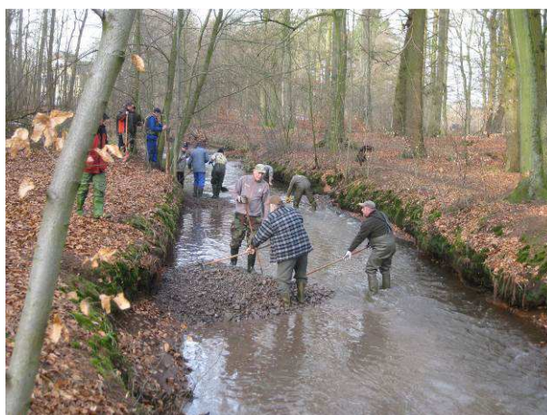
Aanbrengen van 'dood-hout vangere' en kiezelbedden.
