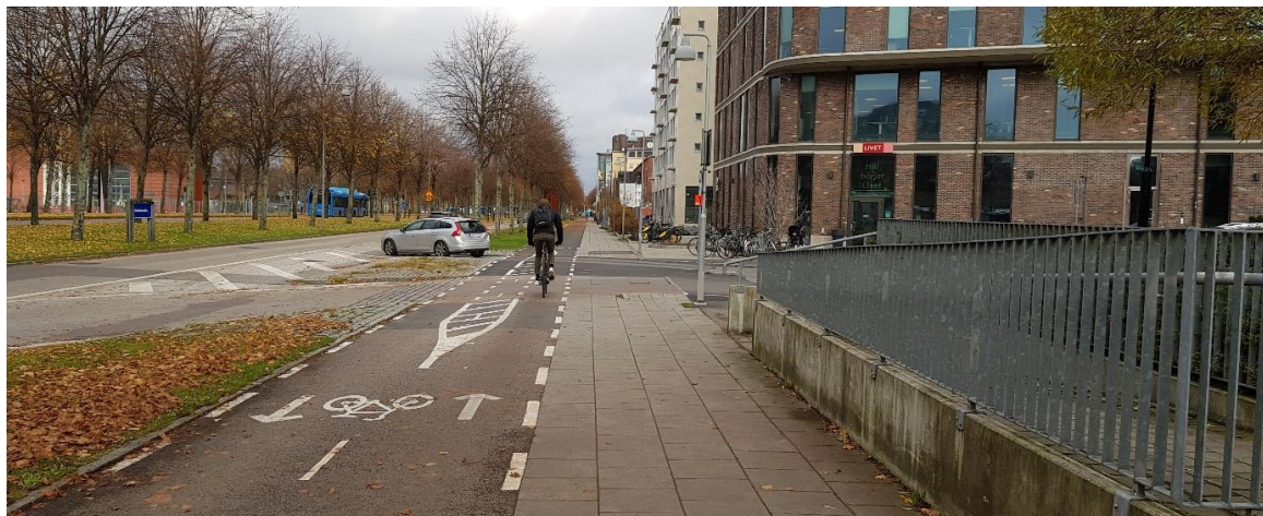
Figur 14. Exempel på visuell målning som i detta fall ger känslan av en avsmalnad cykelväg innan korsning, med syfte att sänka cyklisternas hastighet. Cykelbana på Lindholmen i Göteborg. Foto: Jones Karlström, VTI.
