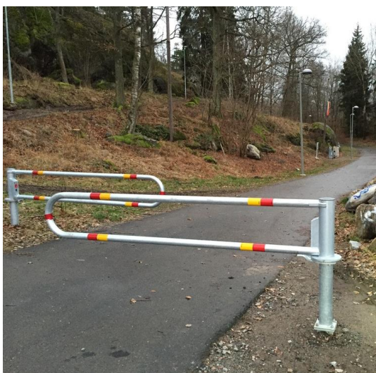
Figur 12. Hastighetsdämpande grindar på cykelbana: Foto: Mattias Bengtsson Byström. Källa: Isaksson, 2016 23
