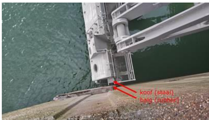
Figuur 2: Lekkage balgen Haringvlietsluizen: in totaal zijn er in de Haringvlietsluizen 34 balgen aan de rivierzijde (2 per schuif) die opgeblazen worden om lekkage te beperken. Een deel van de balgen aan de rivierzijde functioneerde niet goed in 2018 wat resulteerde in een kleine continue zoutlek. In de periode februari-maart 2018 zijn daarom de balgen vervangen door Rijkswaterstaat. In deze vervangingsperiode is er sprake geweest van een zoutlek en daarmee opening voor kleine vissen tot aan de periode waarop de balgen zijn opgeblazen. De zoutlek is over een breedte van 1 cm (bij een waterhoogte van 5 m is het dus ca. 0,05 m 2 per balg). Op 19 juli 2018 waren 29 van de 34 balgen weer opgeblazen en kort daarna de rest.
