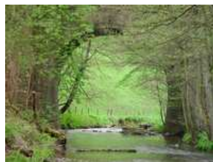
Brug over de Geul
