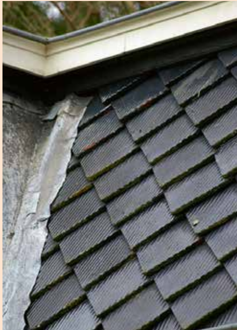
Afb. 10 (rechts boven) Deel van de gevel van het in 1910 gebouwde fabrieksgebouw van de Dakpannenfabriek "De Valk" Fa. J. Meuwissen te Echt.
