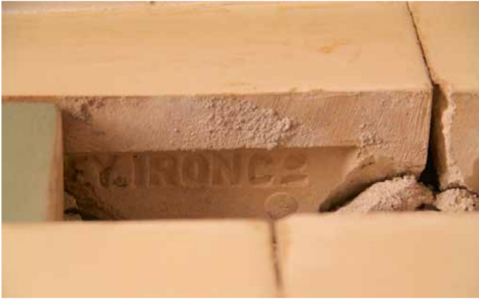
Afb. 47 Detail van vuurvaste steen gemaakt door de Farnley Iron Company uit Leeds toegepast in een kluis in het herenhuis Herengracht 380-382 te Amsterdam.
