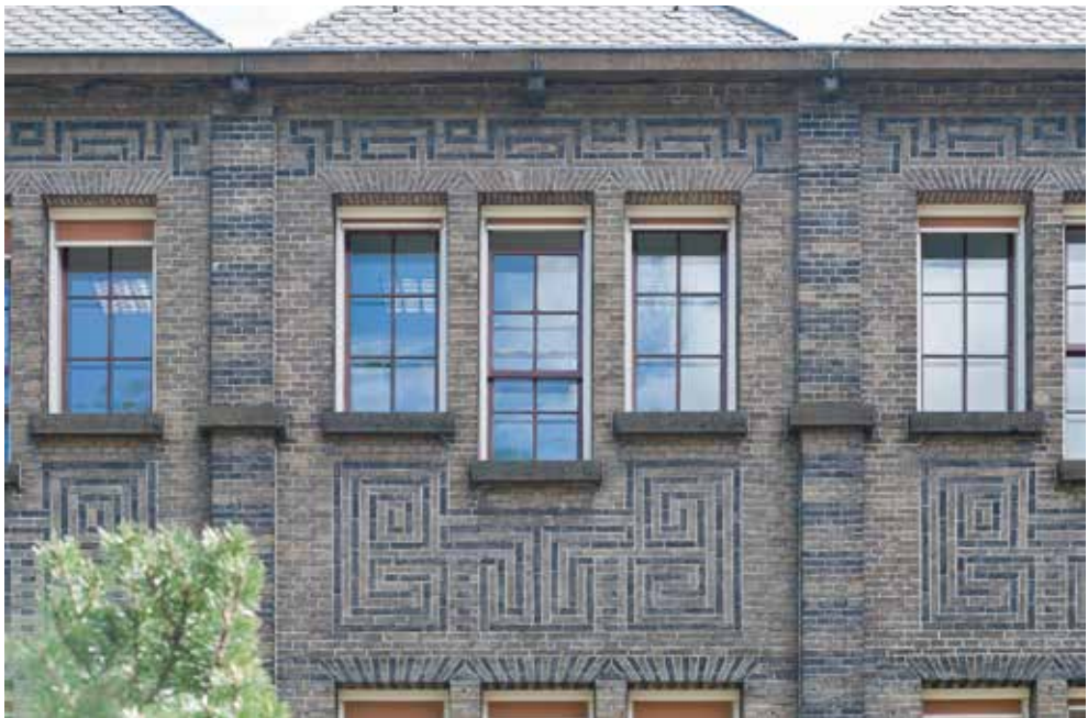
Afb. 4 (onder) Deel van het met- selwerk aan het hoofdkantoor van de Nederlandsche Heidemaatschappij te Arnhem uit 1912-1914, met meandervormen in gesmoorde baksteen.
