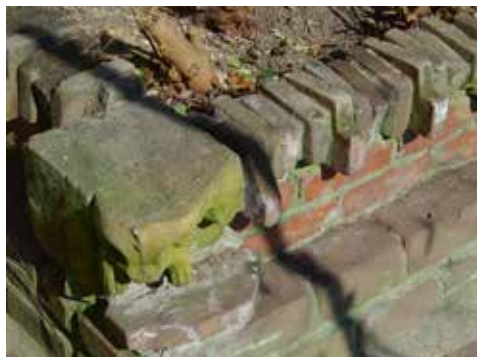
Afb. 21 Detail van een tuinmuur van Huize Uiterwaarde te Opijnen opgebouwd uit ter- racotta elementen en profielstenen bedoeld voor het Amsterdamse Scheepvaarthuis.
