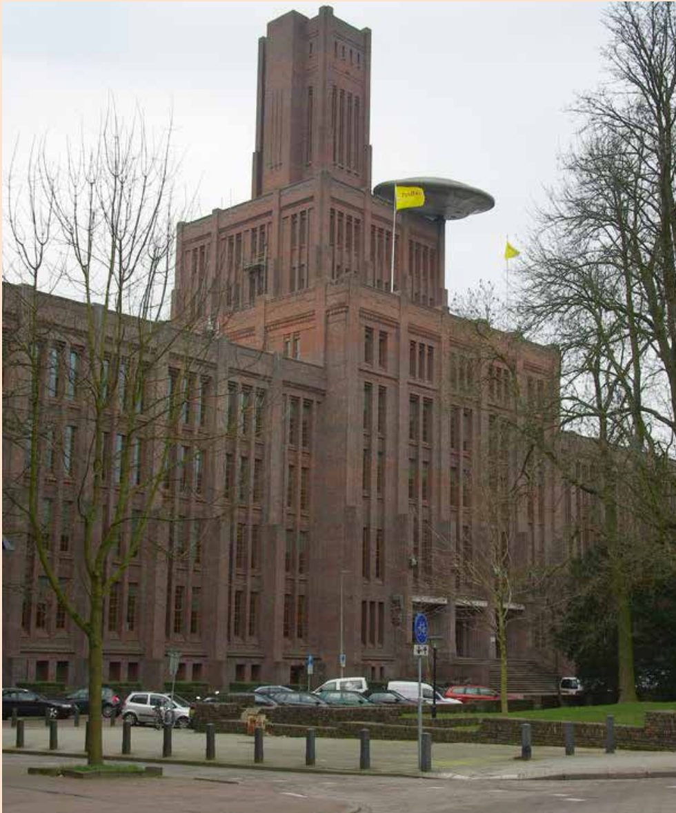
Afb. 4 (boven) Hoofdgebouw III van de Nederlandse Spoorwegen aan het Moreelsepark in Utrecht voltooid in 1921 na verwerking van 21 miljoen bakstenen.
