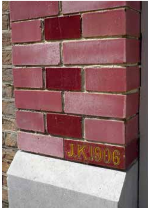
Afb. 19 (links) Deel van de gebouwen op het perroneiland van het station te Haarlem uit 1905-1908 met lichte en geglaazuurde verblendsteen.
