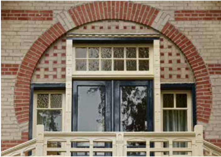
Afb. 11 (links) Deel van de villa Prins Mauritslaan 9 te Apeldoorn uit 1909, waar rode baksteen ter decoratie is gebruikt in de gevels van kalkzand- steen.
