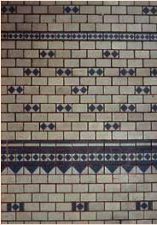
Afb. 33 (links onder) Deel van een gevel met witte verblendsteen en Bricorna-steenjes aan het clubgebouw De Maas te Rotterdam uit 1908.
