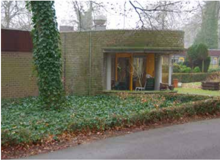
Afb. 17 (rechts) Eén van de onderkoms van het in 1967 gereed gekomen Het Dorp in Arnhem waar van de buitenmuren werden opgetrokken uit 'Vlamovenstraat-klinkers'.
