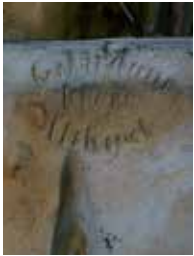
Afb. 2 (rechts) Gesmoorde platte Friese pan op een dorpswoning in het Friese Stedum uit circa 1890.
