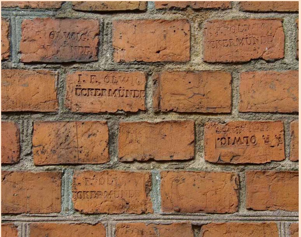
Afb. 5 (onder) Deel van de muur van het Fort Aniola in Swinoujscie (Polen), gebouwd in 1854-1858 en versterkt in 1870- 1880 met bakstenen die aan de buitenszijde van naamstempels van steenfabrikant uit de omgeving zijn voorzien.
