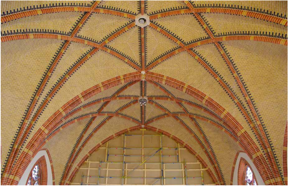
Afb. 11 Deel van de gewelven van de r.k. St.-Barbarakerk te Nieuwegein uit 1909-1910, met voor de ribben rode baksteen, afgezoomd met gesmoorde baksteen, en voor de velden kleine gele baksteen.
