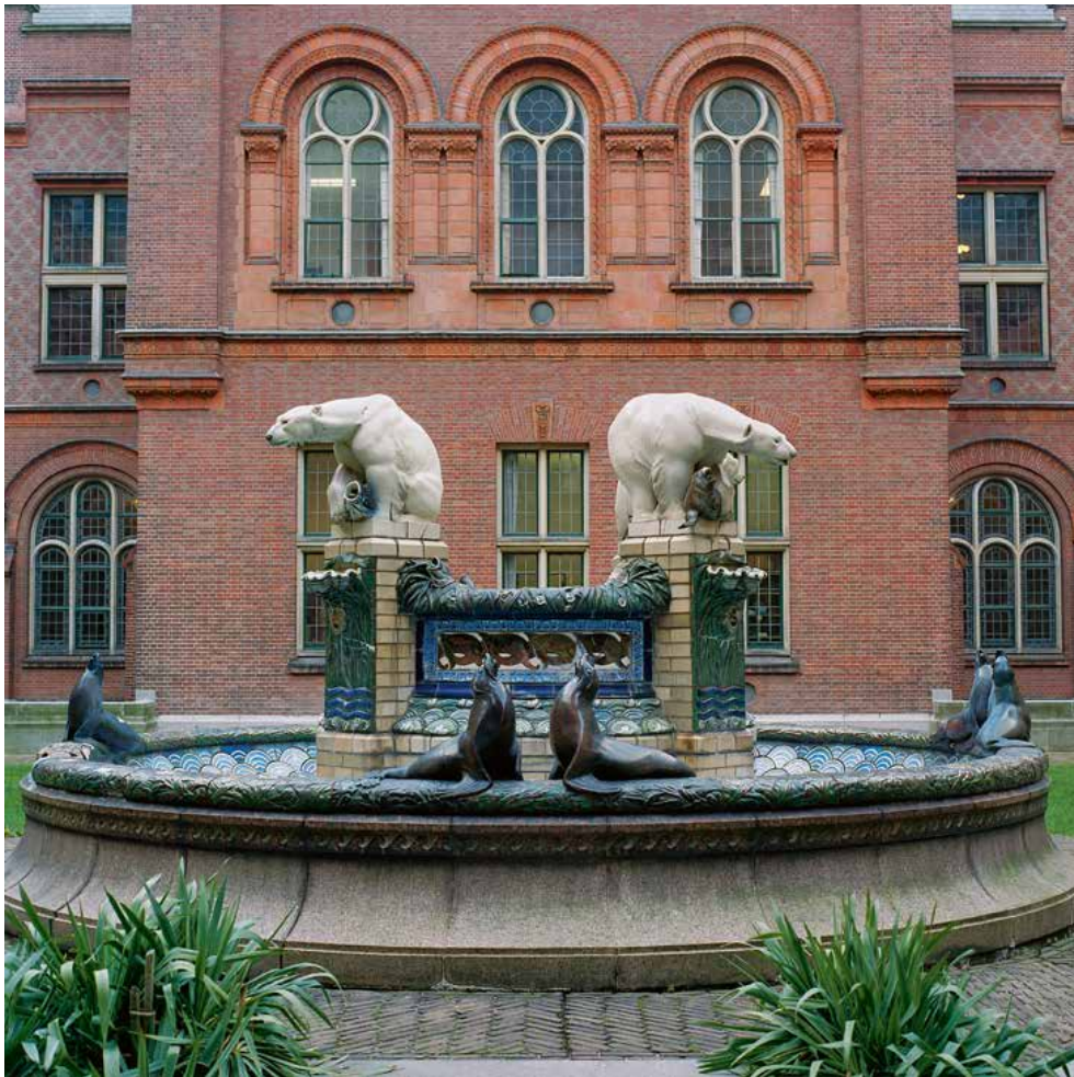
Afb. 39 Deel van de binnenplaats van het Vredespaleis te Den Haag 1908-1913. Aan de buitengevels werden grotere en op de binnenplaatsen werden bakstenen in waalformaat gebruikt.
