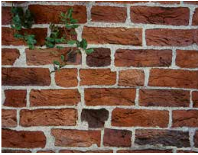
Afb. 7 (links) Deel van de muur van het Steinhaus te Bunderhee (Oost-Friesland) met veertiende-eeuwse baksteen waarin goed de 'drukbogen' goed zichtbaar zijn, ontstaan bij het persen van de klei in de vorm.
