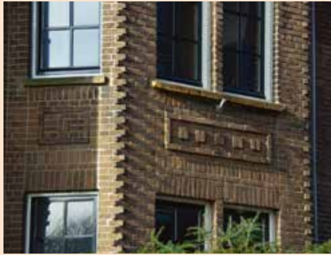
Afb. 36 (links boven) Siermetselwerk in de vorm van een rechtopstaand en blokverband aan het Derde Blok van de Woningbouwvereniging Eigen Haard in Amsterdam uit 1917-1920.
