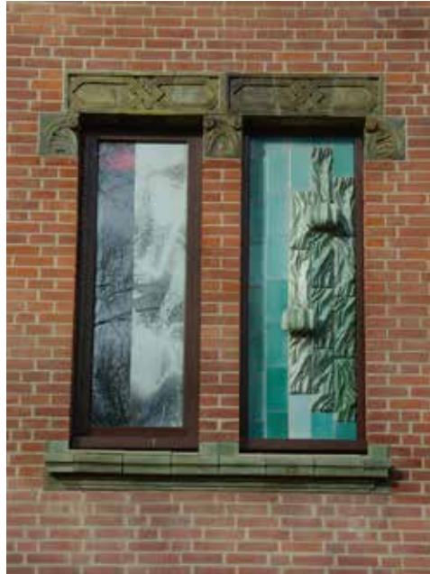
Afb. 26 (links boven) De Triodosbank aan de Utrechtseweg te Zeist uit 1999, waar bij de bouw oude bakstenen zijn hergebruikt.
