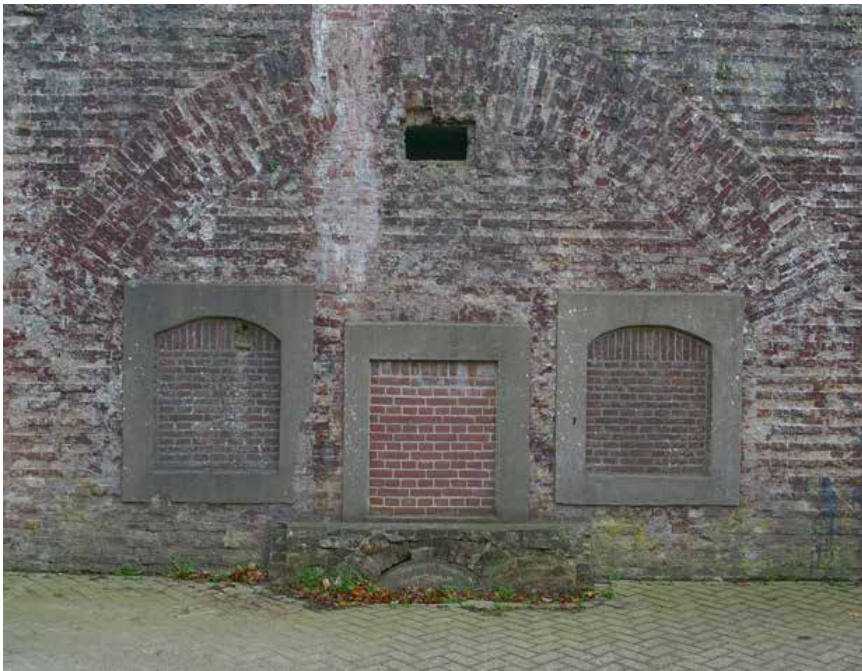
Afb. 30 (links) Deel van het muurwerk van Fort Vossegat te Utrecht uit 1850 met afgedrukte buitenschil.
