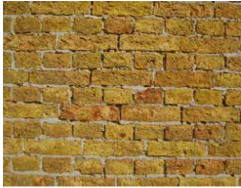
Afb. 7 (links) Deel van het muurwerk van het gebouw van de Maatschappij tot Nut van 't Algemeen te Leiden uit 1850, opgetrokken uit rode baksteen met gele plekken.
