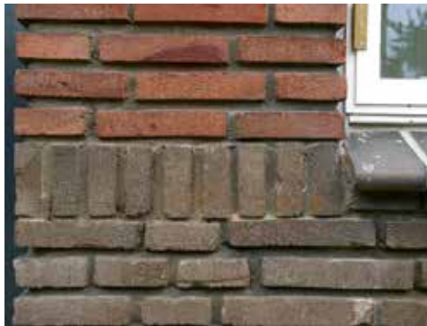
Afb. 46 (rechts onder) Details van 'gerilde' klinker en gevelsteen aan de uitbreiding van 1934 van de voormalige Koninklijke Tricotfabriek G.J. Willink te Winterswijk.
