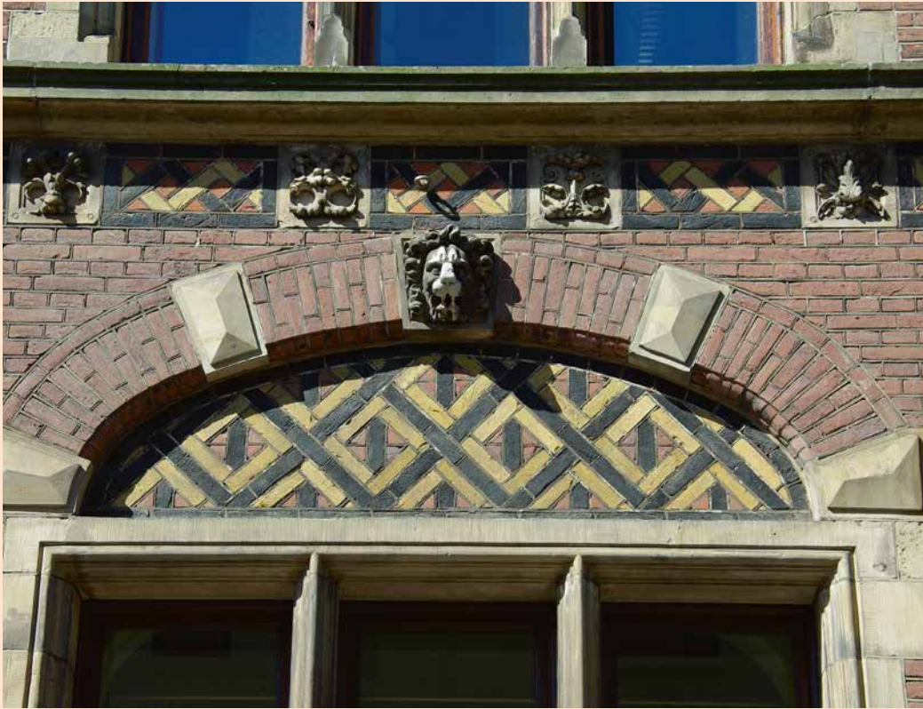
Afb. 21 (boven) Boog en vensterboogvulling van het voormalige Ministerie van Justitie te Den Haag uit 1877-1883 aan het Plein in met een baksteenmozaïek van rode, gele en gesmoorde steen.
