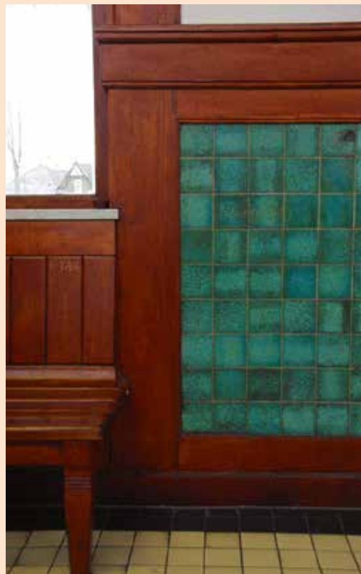
Afb. 27 (links onder) Wand- en vloertegels gemaakt door de tegelfabriek Schiedam in de voormalige Ambachtschool te Zwolle uit 1932-1934.
