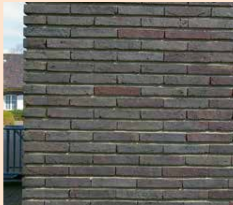
Afb. 6 (rechts midden) Detail van de platte blauwgrijze baksteen met dikke teruglig- gende stootvoegen en dunne stootvoegen aan het Officerscasino te Soesterberg uit 1941.
