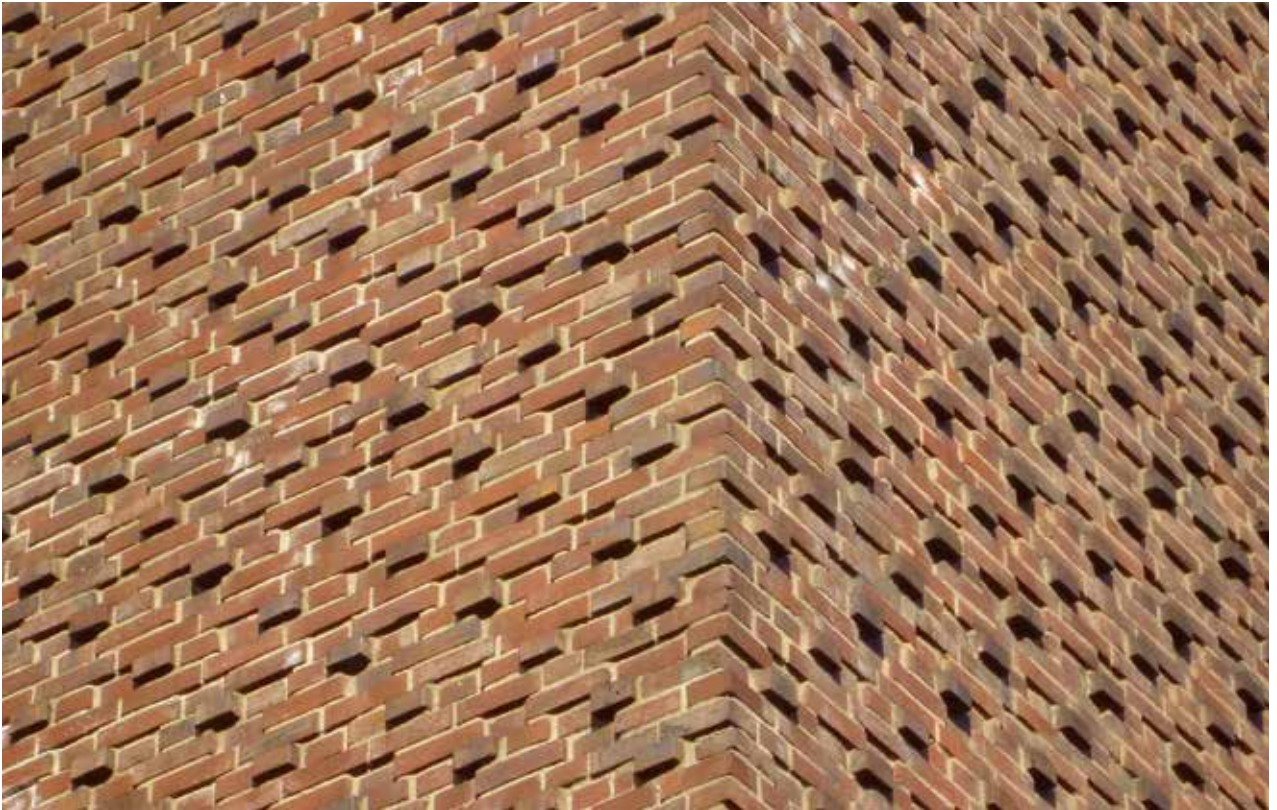
Afb. 4 Detail van de toren van de r.k. St.-Dominicus aan de Hang te Rotter- dam met 'driedimen- sionaal' metselwerk.
