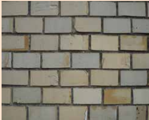
Afb. 22 (rechts boven) Detail van een vensterbank aan de Adriaan van Ostade- laan te Utrecht met de strengpersgaten nog zichtbaar.
