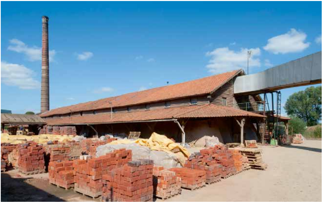
Afb. 2 Overzicht van de in 1919 gebouwde ringoven van steenfabriek Vogelensangh te Deest.
