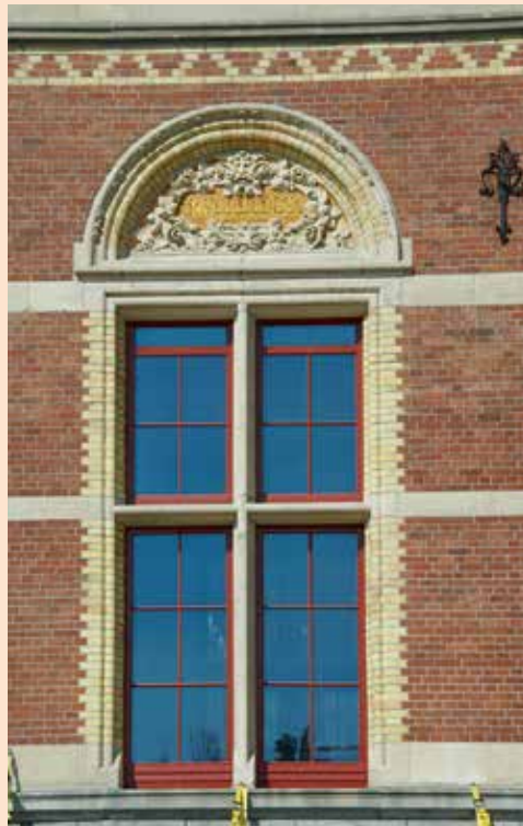
Afb. 9 (links) Detail uit de map voor de staten van de profielstenen voor de bouw van het Rijksmuseum te Amsterdam uit 1881.
