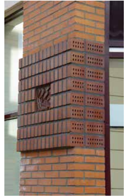
Afb. 21 (links) Woningbouw Vondelparc in Utrecht uit 2001 in wild verband en niet meer ‘aan de draad’ gemetselde kromgetrokken baksteen.
