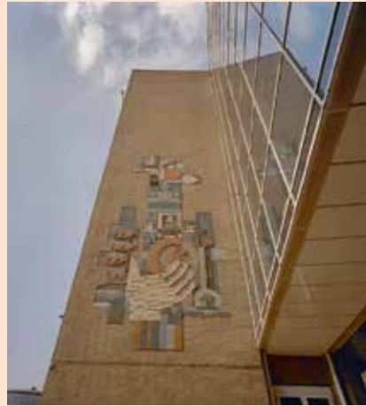
Afb. 44 (links) Detail van een borst- weringpaneel dat als geprefabriceerd werk werd uitgevoerd aan het kantoorgebouw van de ANWB te Den Haag uit 1958-1959.
