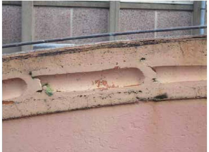
Afb. 63 (links) Het inmiddels gesloopte station van Arnhem uit 1954 waar voor de gebogen daken fusées werden toegepast.
