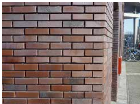
Afb. 18 (rechts onder) Deel van voegloos muurwerk hoek Stationsstraat en Brouwersstraat te Amersfoort uit circa 2005.
