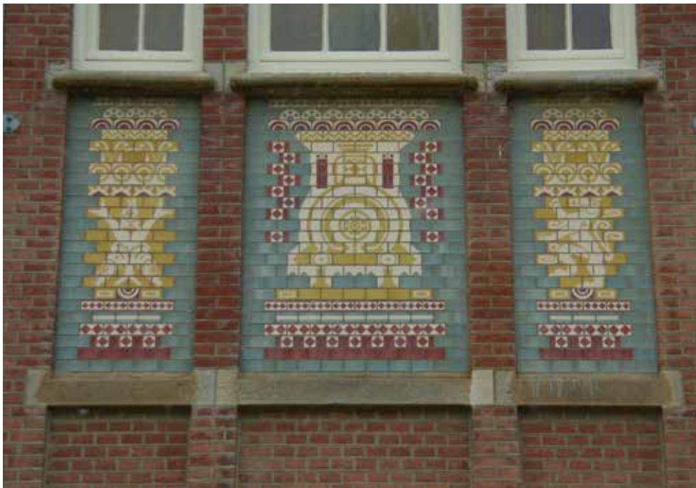
Afb. 3 Baksteenpaneel opgebouwd uit speciaal voor dit ontwerp gemaakte Bricornastenen aan het station te Zandvoort uit 1908.
