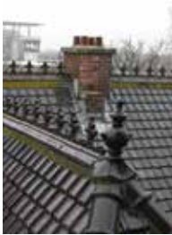
Afb. 15 (links) Geglazuurde pannen, nokvorsten met dak-kammen en broekstuk met piron op het dak van de bijgebouwen van de Remonstrantse kerk te Rotterdam uit 1897. Het bestek sprak van 'blauwe Echtsche kruispannen', maar het zijn – waarschijnlijk ook te Echt vervaardigde – 'Tuile du Nord's' geworden.
