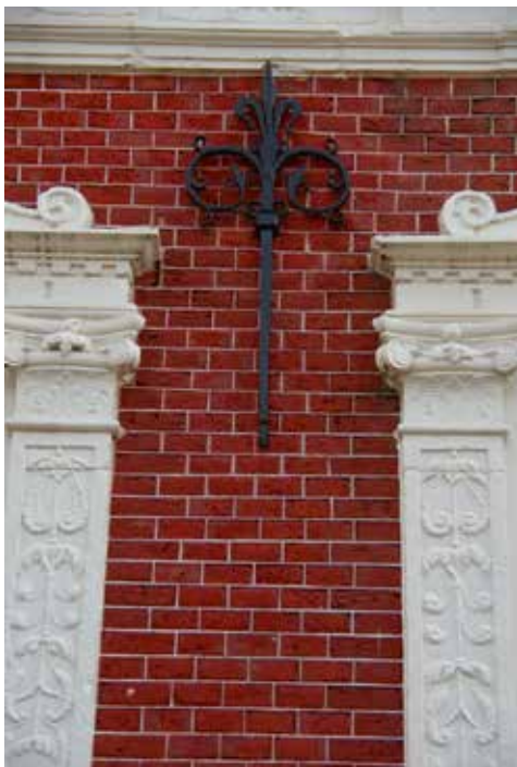
Afb. 17 (rechts) Deel van het muurwerk van het woonhuis Heereweg 389 te Hargen bij Schoorl, opgetrokken rond 1866 met halfsteensmuren in halfsteensverband. Rechts naast de hemelwaterafvoer zijn de koppen zichtbaar van een intanding van een haakse binnenmuur.
