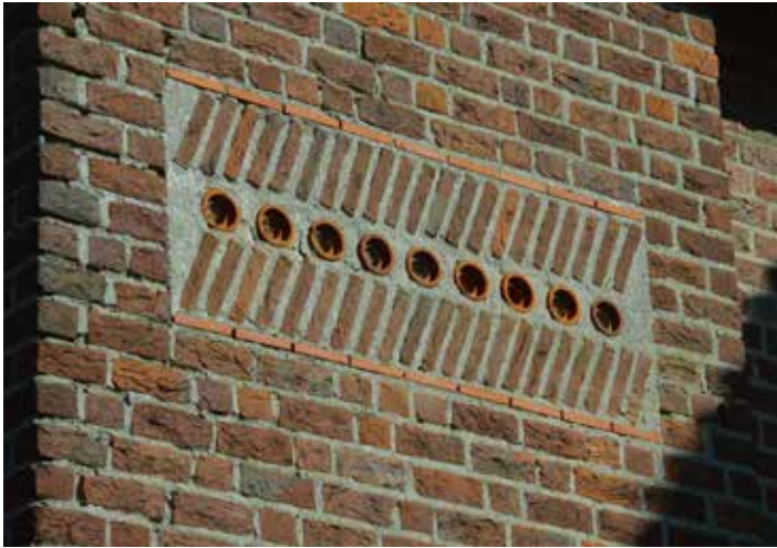
Afb. 33 (links) Detail van de r.k. St.-Martinuskerk te Kerkdriel uit 1953-1955, met een aantal fusées verwerkt in het siermet- selwerk.
