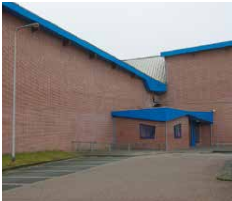
Afb. 14 (onder) Deel van de gevels van het Sportcentrum De Scheg te Deventer uit 1989-1993 met gemetselde diafragma-wanden.
