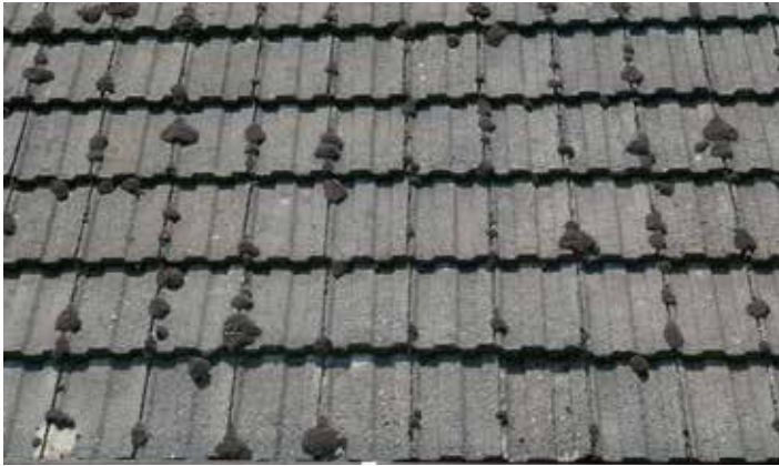
Afb. 18 (links) Dak in Genemuiden, gedekt met cementpan van een type gelijkend op de Victoria-cement- pannen.
