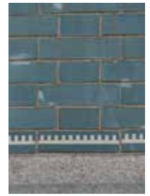
Afb. 28 Detail van geëngobeerde baksteen in de gevel van de Fries-Groningse Hypotheekbank aan de Herengracht te Amsterdam uit 1906.
