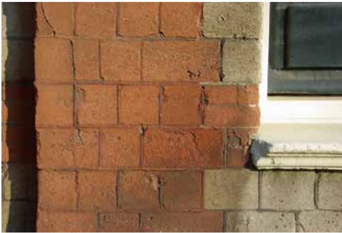
Afb. 2 (links) Detail van het hoekhuis aan de Amsteldijk met kunstzandsteen in de kleuren rood en crèmewit in een dub-beldik formaat gemaakt door de Nederlandsche kunstzandsteenfabriek te Velsen .
