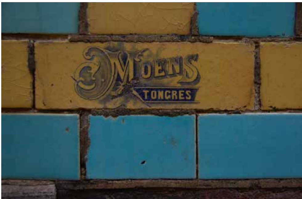
Afb. 11 Detail van een geglazuurde baksteen met fabrieksmerk op een woonhuisgevel aan de Sint-Jansstraat te Tongeren in Belgisch Limburg.
