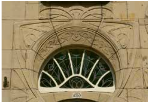
Afb. 6 (geheel links) Herenhuis aan de Laan van Meerdervoort te Den Haag uit 1901 met gevels van kunst- zandsteen vervaardigd door de Haagse fabriek Kranenburg .
