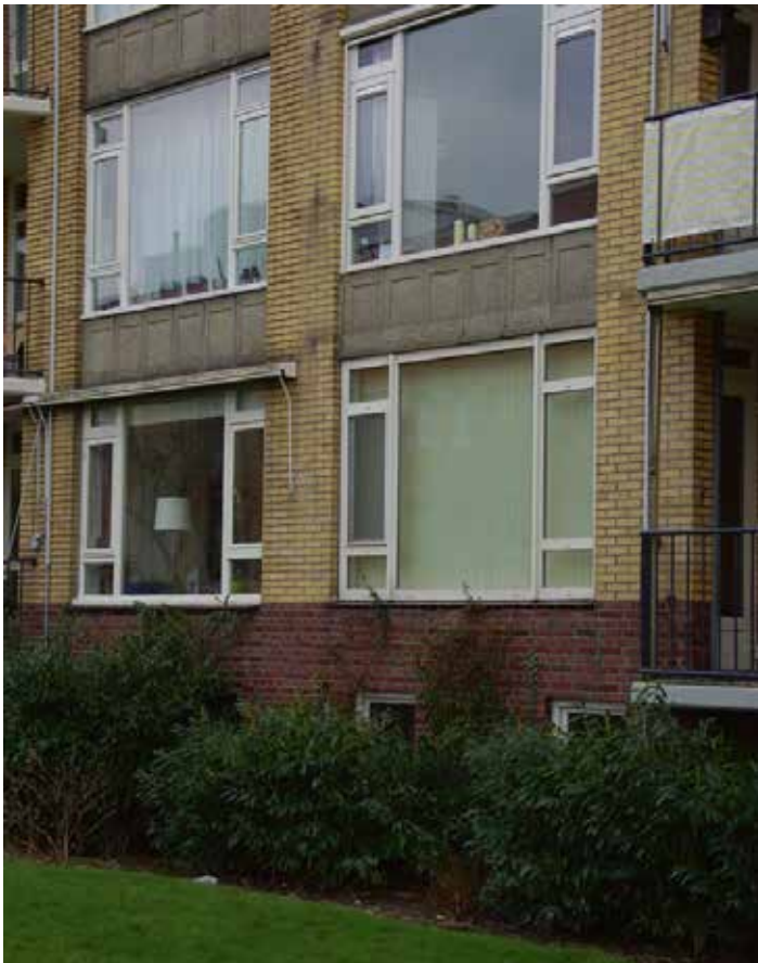
Afb. 16 (links) Deel van de flats aan het Tolsteegplantsoen in Utrecht uit 1957, met een combinatie van gele baksteen en betonelementen voor de borstweringen.
