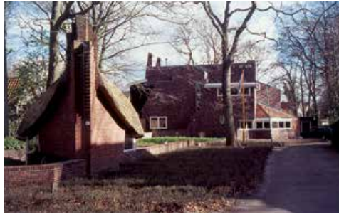
Afb. 10 Villa De Ark met tuinhuis op de voorgrond in het Park Meerwijk te Bergen uit 1917.
