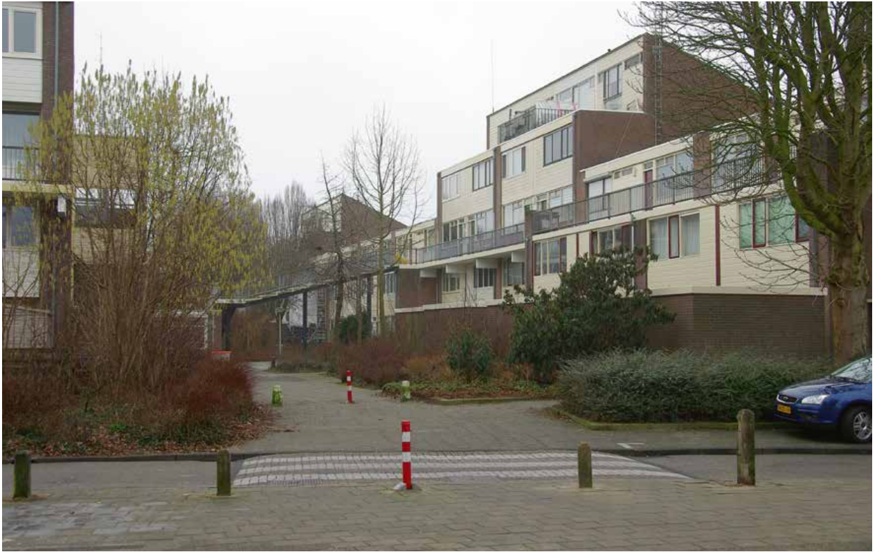
Afb. 3 Deel van de woonwijk Het Oostrik te Deventer uit 1972-1974, met maximaal vijf bouwlagen in betonskeletbouw en bakstenen gevels.
