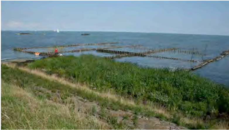
Foto 6 Alle zandvakken, 2014. Op de voorgrond is het spontaan dichtgeslibte gebied (met rijke pioniervegetatie) tussen de dijk en de Marker Kwelderwerken zichtbaar.
