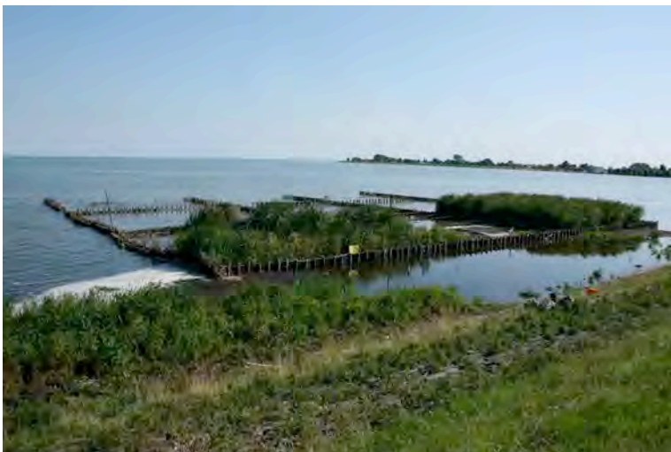
Foto 7 Alle slibvakken, 2014. Op de voorgrond is het spontaan dichtgeslibte gebied (met rijke pioniervegetatie) tussen de dijk en de Marker Kwelderwerken zichtbaar.
