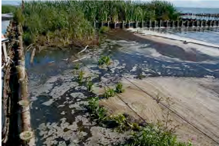
Foto 4 Slibvak S2a (controlevak), 2014. De waterdiepte in dit vak was in 2013 1,5 meter. Als gevolg van spontane aanslibbing van weinig slib in dit controlevak stonden in 2014 delen van dit vak droog. Emerse vegetatie kreeg daar kans zich te vestigen en te ontwikkelen tot een rijke pioniervegetatie. Foto Bureau Waardenburg, Rob van de Haterd.
