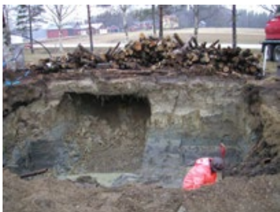
Figur 1:2 Schaktning vid saneringen i Kasamark.
