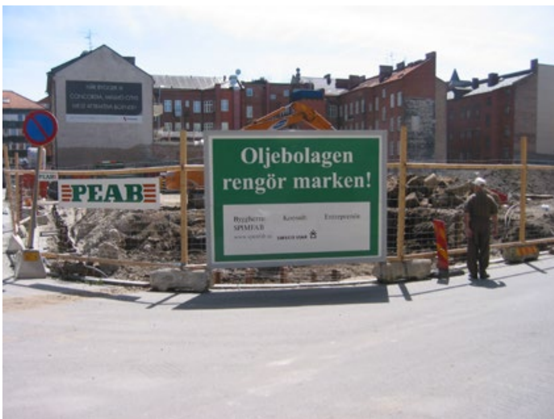
Figur 1:6 Sanering pågår vid Baltzarsgatan i Malmö.
