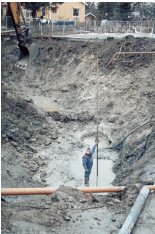
Figur 1:4 Schaktgrop vid Sävsta.
