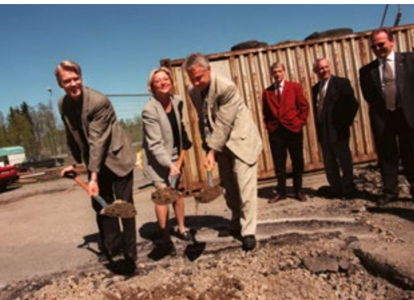
Figur 1 "STOCKHOLM 13 MAJ 98 Anders Linder (s), kommunalråd i Tyresö, miljöminister Anna Lindh och Bengt Westerberg, ordförande i SPI miljösaneringsfond tar första spadtaget vid reningen av den nedlagda OK-macken vid Siklöjevägen 1 i Tyresö. Det är oljebolagens gemensamma miljösaneringsfond, SPIMFAB, som ansvarar för reningen. Under de närmaste åren skall tusentals gamla bensinstationer över hela landet undersökas och renas. Macken i Tyresö är den första som renas i mellansverige." (TT Nyhetsbyrån).
